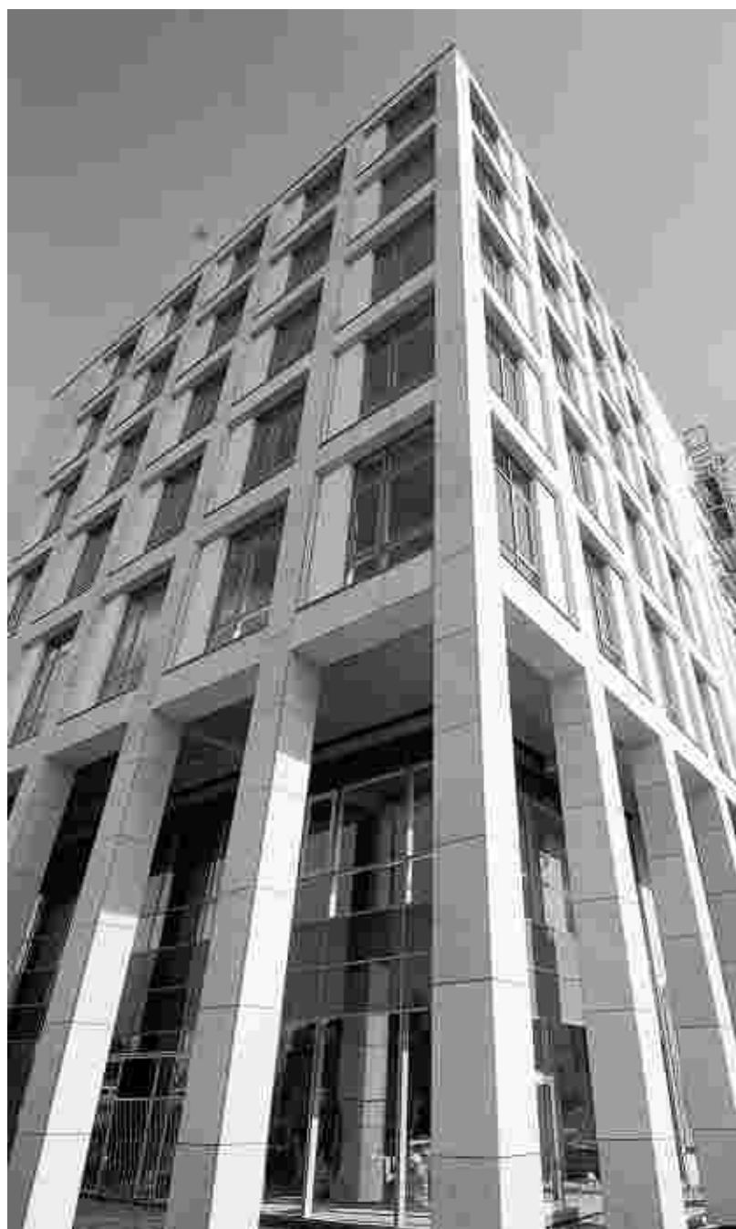
Neuer Blickfang im Ostviertel: Die Aachen-Arkaden – hier der prägnante Büroturm – eröffnen in weniger als drei Wochen. Foto: Wolfgang Pitzner
